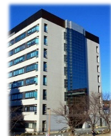
西9号館 コラボレーション ルーム
