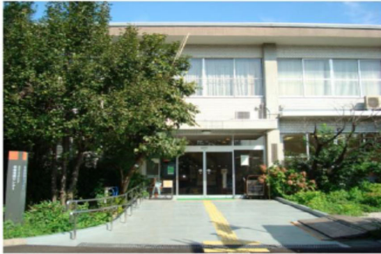
東京工業大学保健管理センター Tokyo Institute of Technology Health Service Center
