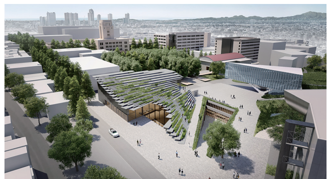
提供：隈研吾建築都市設計事務所
